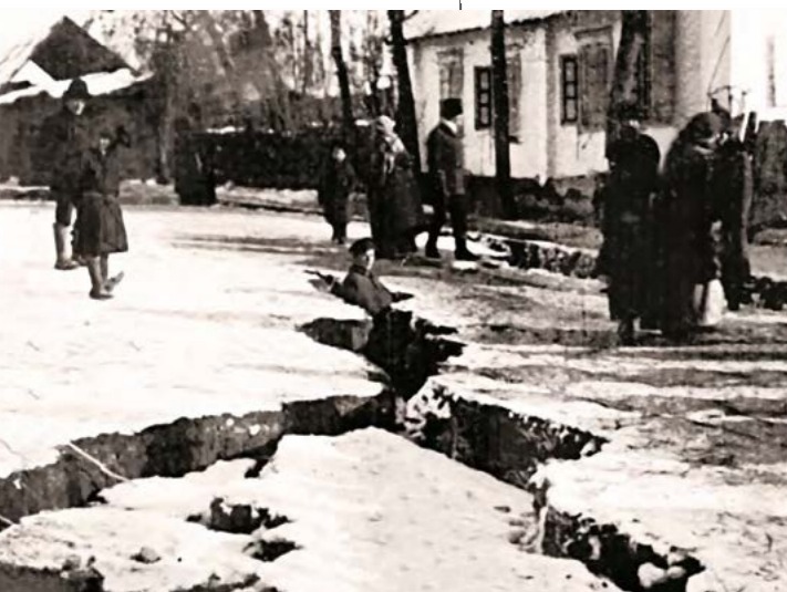
Трещины после землетрясения. Фото 1911 года
