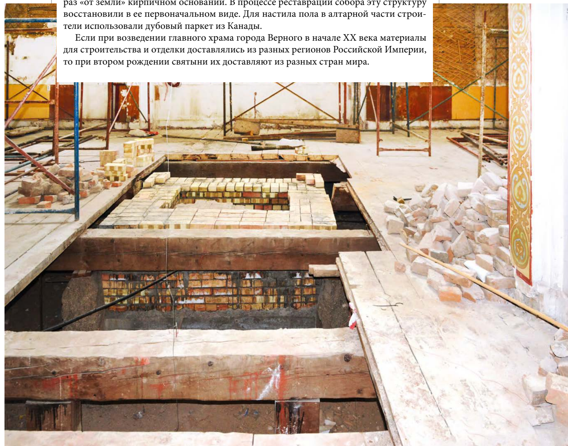
Реставрация кирпичного основания центрального престола. 2018 год
