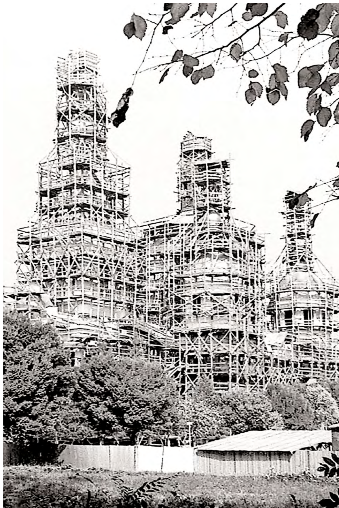
Реставрация собора. Фото 1973 года
