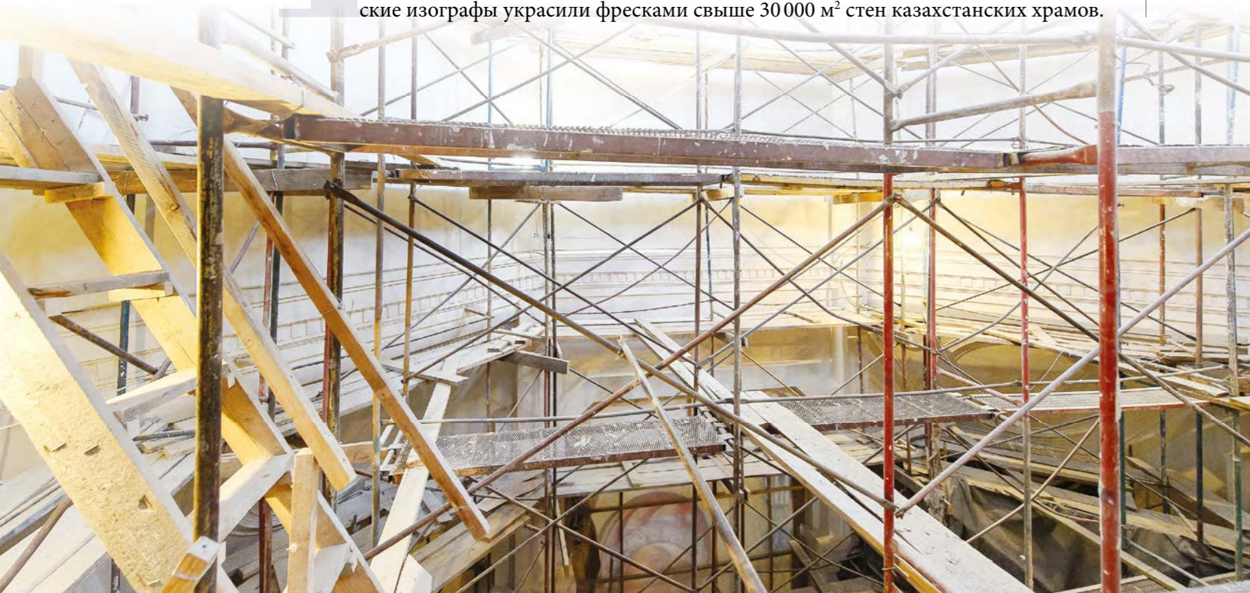
Леса, установленные в центральной части собора для росписи стен и сводов. 2019 год
